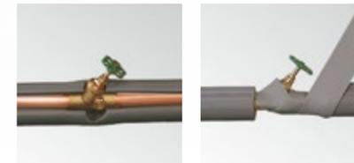
Découpez dans le tube isolant une ouverture correspondant au diamètre de la vanne. Ouvrez le tube et, à l'aide d'un cutter, évidez le pourtour de l'ouverture pour permettre un accès au pas de vis. Les endroits difficilement accessibles peuvent être isolés rapidement et simplement à l'aide de la bande adhésive en PE.
