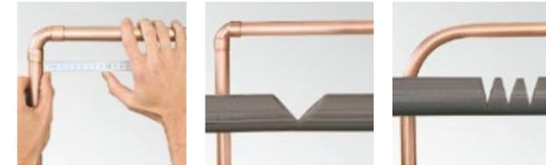
Déterminez d'abord le rayon: placez un mètre à une extrémité du coude et repérez l'autre extrémité avec le pouce. Dans notre exemple, le rayon est d'environ 2,5 cm.
