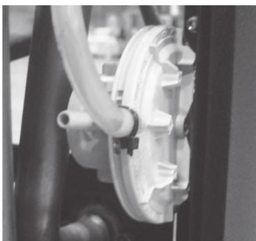
**Pressostat fumées:** il contrôle la pression dans le conduit de fumée. Il sert à bloquer la vis sans fin au cas où la sortie de fumées serait bouchée et en cas de contre-pressions importantes par exemple en présence de vent.
