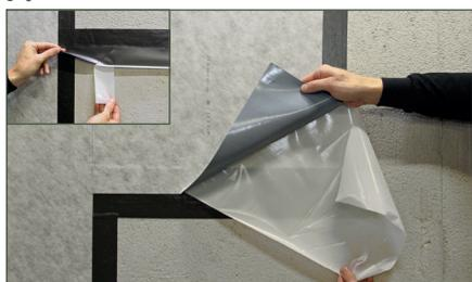
Pour les raccordements horizontaux entre les différentes bandes d'étanchéité Blanke Disk, il faut appliquer la Blanke Disk Tape sous les raccordements. Ensuite, le dessus et le dessous des deux bandes d'étanchéité doivent être collés sur la Blanke Disk Tape Tape avec un chevauchement d'au moins 5 cm.
