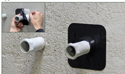
Les passages de tuyaux doivent être également étanchés avec les manchettes de paroi et de sol Blanke Disk WM/BM avant d'appliquer la bande d'étanchéité Blanke Disk. Veillez à la formation d'un bourrelet professionnel de la manchette d'étanchéité au raccordement avec le passage.
