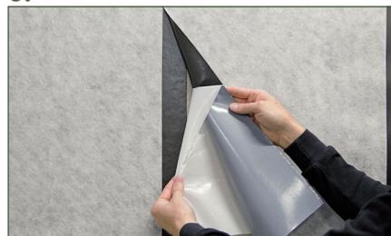
Les bandes d'étanchéité suivantes doivent toujours être appliquées sur la partie sans membrane avec la bande d'étanchéité Blanke Disk et être comprimées avec la main également sans bulles d'air. Blanke Disk est découpée à dimension avec un couteau de découpe.
