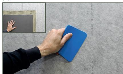
Après le collage, Blanke Disk doit toujours être comprimé avec la spatule de compression Blanke Disk Tool fournie de manière à créer une adhésion optimale de tous les composants avec le support. Ensuite, le carrelage ou le revêtement en pierre naturelle peut être appliqué avec une colle pour carreaux appropriée.
