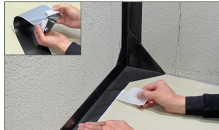
La Blanke Disk Tape est appliquée sur toutes les parties angulaires horizontales et verticales. Enlevez la feuille appliquée à l'arrière sur environ 5 cm de la pièce latérale. Appliquez la bande d'étanchéité d'angle sur le support et exercez une pression avec la main de manière à éviter les bulles d'air. Veillez à ce qu'il y ait des recouvrements de  $\pm 5$  cm entre les différents éléments.
