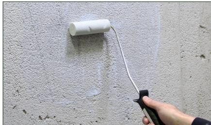
Appliquez une couche d'apprêt/de primaire régulatrice d'étanchéité sur le support plat et laissez sécher suffisamment, en fonction du support et de la température ambiante, ce délai sera compris entre 6 et 12 heures.
