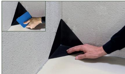
Appliquez la pièce d'angle Blanke Disk Corn dans les angles intérieurs et extérieurs. La pose doit être faite après avoir enlevé de la feuille de couverture sur le dos. Grâce à l'utilisation du Blanke Disk Tool, les pièces d'angle peuvent être appliquées avec précision dans les coins.
